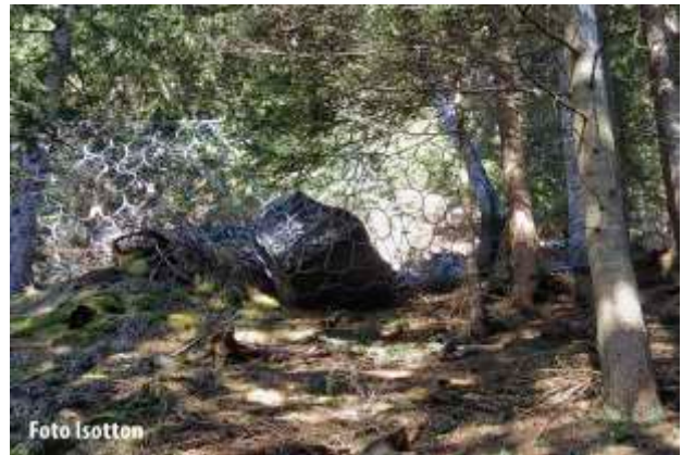
Fig. 9 - Barriera paramassi impattata.
