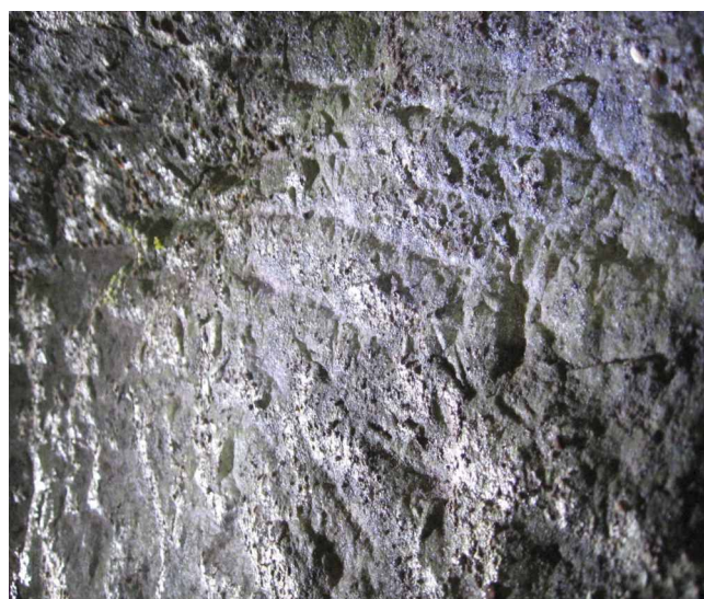
Fig. 8 - I segni lasciati sulle pareti dalle operazioni di scavo eseguite a mano.
