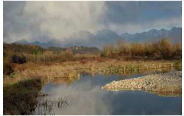
Fig. 9 - Pozza di decantazione, abbondantemente ricoperta da vegetazione, poco a monte del Ponte di San Felice.
