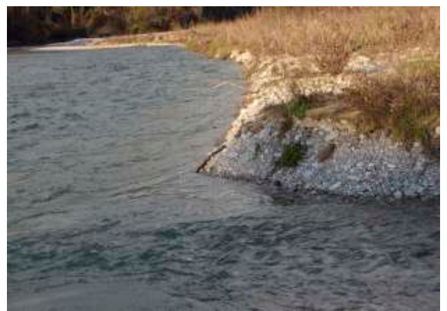
Fig. 5 - La sponda del canale principale del fiume Piave.
