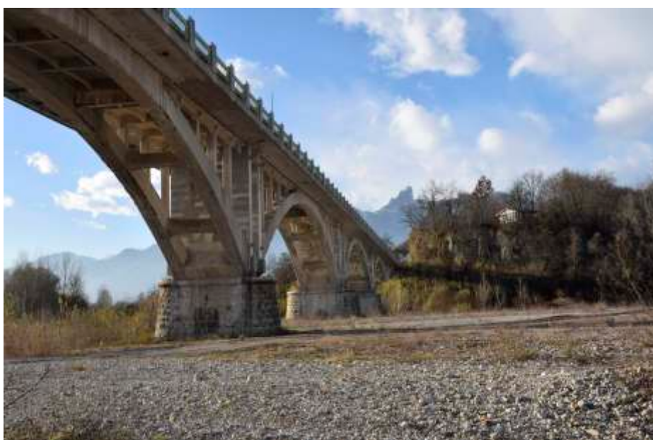
Fig. 2 - Il letto della Piave all'altezza del Ponte di San Felice.
