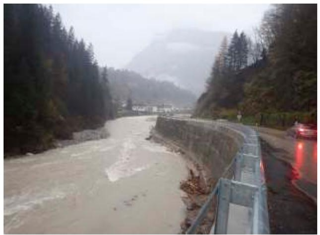
9 - Il cedimento descritto nella figura precedente con ben visibile l'azione erosiva delle acque del T. Cordevole nei pressi di Cencenighe.
