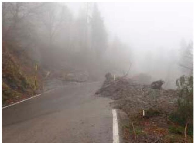
3a - Lo smottamento prima del tornante della figura precedente con cedimento dei gabbioni di sassi e colate fangose fin sotto la sede stradale.
