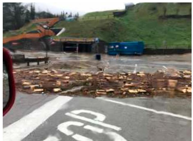
2 - Il parcheggio sotterraneo di Alleghe è costruito allo stesso livello del letto del Torrente Zunaia ed è soggetto ad elevato rischio alluvionale (foto Gioia Fassa).
