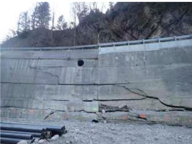
8 - Cedimento del muro di sostegno della sede stradale della 203 Agordina nei pressi di Cencenighe. L'opera di cemento ha subito danni ed è stata asportata la ciclabile per Alleghe. L'intervento di sistemazione ha richiesto l'infissione di pali e la costruzione di una scogliera sul T. Cordevole.
