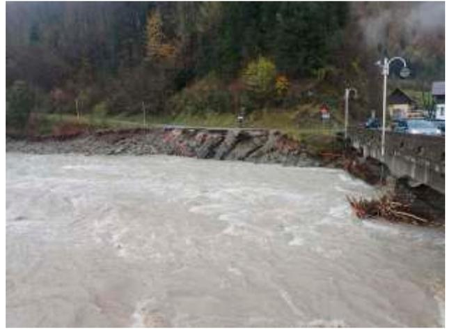
5 - Erosione dell'argine sinistro del T. Cordevole a Cencenighe con interessamento della sede stradale verso la frazione di Avoscàn.
