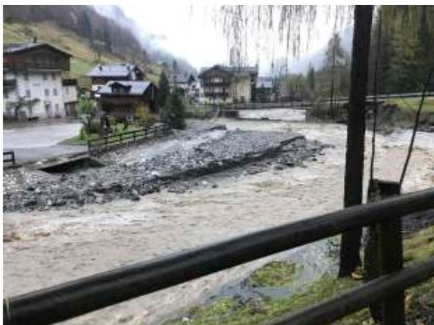
9 - Il T. Pettorina a Sottoguda: i danni limitati al centro del paese sono dovuti alla presenza di argini che hanno permesso il contenimento di parte delle colate detritiche della Valbóna.
