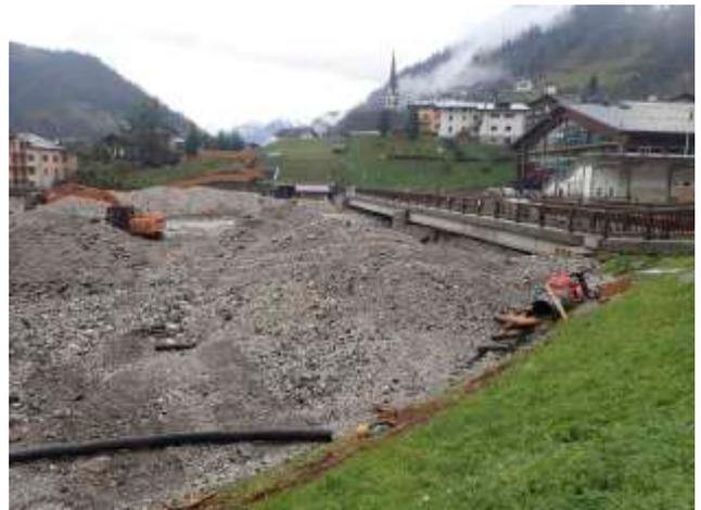
7 - Il ponte sul Torrente Zunaia (Alleghe) quasi completamente ostruito dai detriti scesi dal gruppo del Civetta. Per un soffio si è evitata l'esondazione con danni alle strutture. Anche in questo caso il materiale è stato asportato in breve tempo permettendo al greto del torrente di tornare ad ospitare i parcheggi in vista della stagione sciistica invernale.
