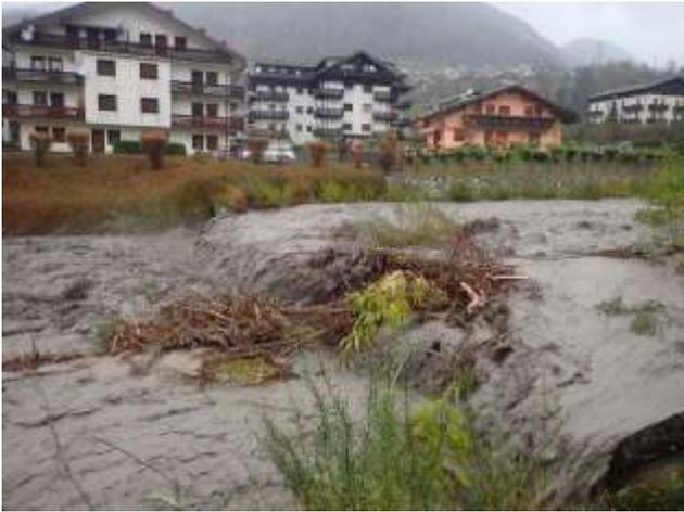
5 - Il Torrente Róva nei pressi di Agordo: nonostante il livello aumentato a causa delle forti piogge l'acqua è rimasta tra gli argini che hanno protetto l'abitato. Si nota anche quanto sia importante la pulizia dei corsi d'acqua per evitare il trasporto di materiale vegetale in occasione di piene.
