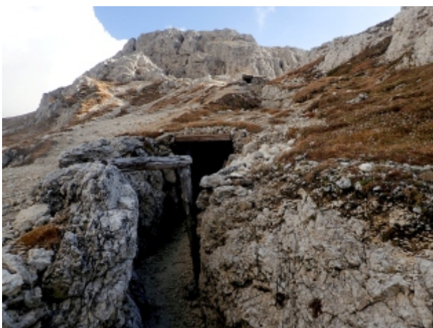
Fig. 22 - Trincee in roccia con copertura di protezione al Sasso di Stria.
