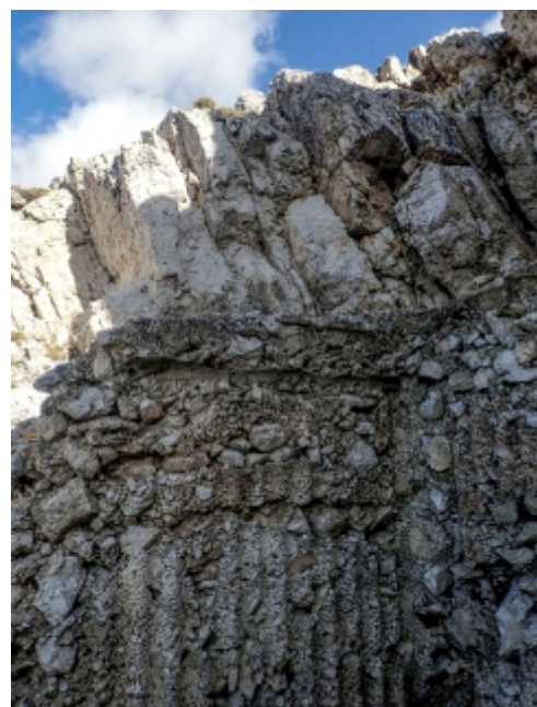
Fig. 23 - Cassaforma ottenuta con lamiera ondulata.
