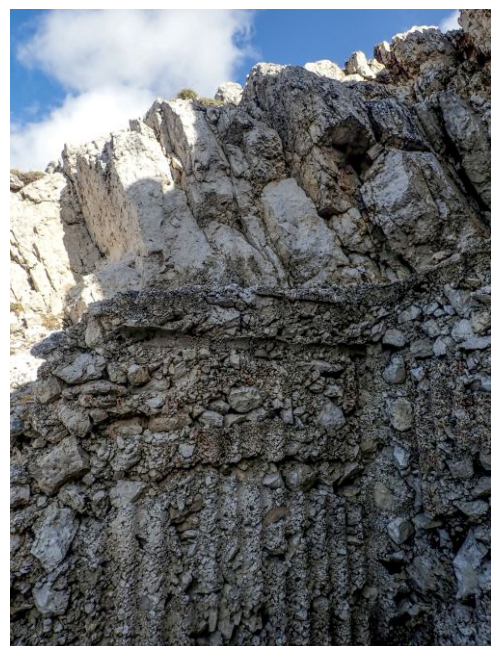
Fig. 23 - Cassaforma ottenuta con lamiera ondulata.
