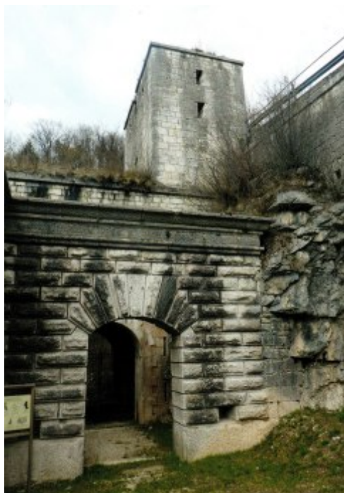
Fig. 6 - Fortificazioni della Tagliata di Primolano costruite con blocchi lavorati di Titoniano Bianco estratti nella vicina cava (Circolo Cultura e Stampa Bellunese, 2019).
