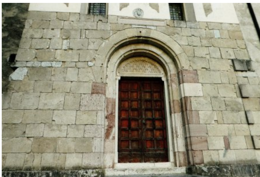
Fig.5 - Facciata del santuario dei Santi Vittore e Corona (Anzù) costruito con conci lapidei quadrati di calcare del Vajont dolomitizzato. Per la realizzazione della porta sono stati impiegati anche elementi di Scaglia Rossa varietà Lastame (Circolo Cultura e Stampa Bellunese, 2019).
