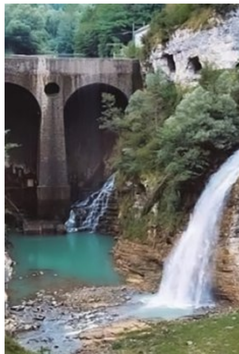
Fig.7 - Diga di Ponte Serra (foto da internet).
