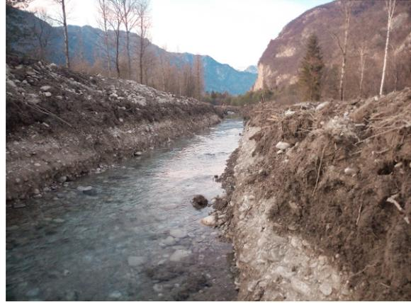
Fig. 8 - Nuovo canale di scolo in costruzione (Foto GM).
