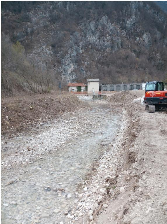
Fig. 9 - Nuovo canale di scolo in costruzione, sullo sfondo Le Pompe (Foto GM).
